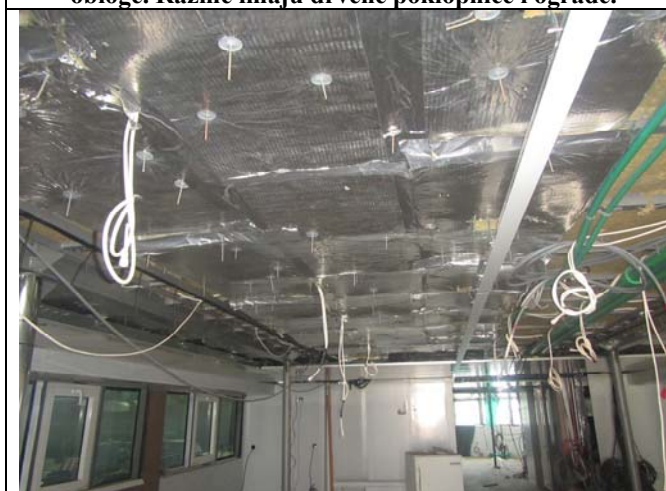
Salon je izoliran i dovedene su instalacije
