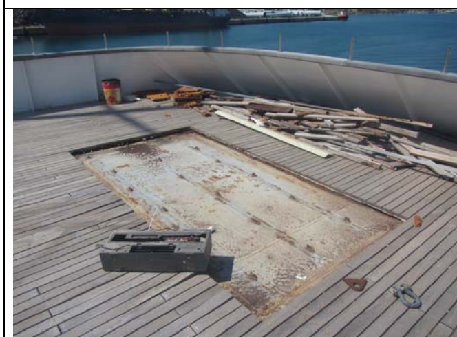
Naknadno izrezani pa zavareni otvor na sunčanoj palubi
