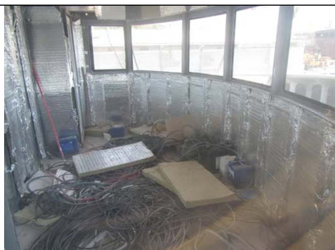
Komandni most je izoliran i dovedeni su razni kablovi
